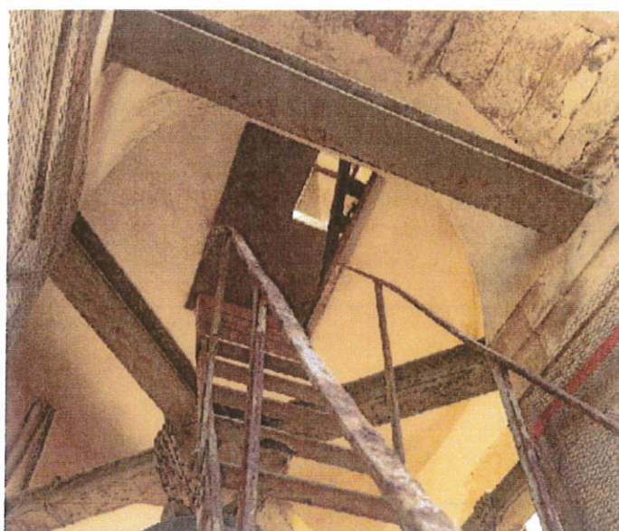
Εικόνα 6. Μεταλλική εσχάρα ανάρτησης κωδώνων βόρειου καμπαναριού
