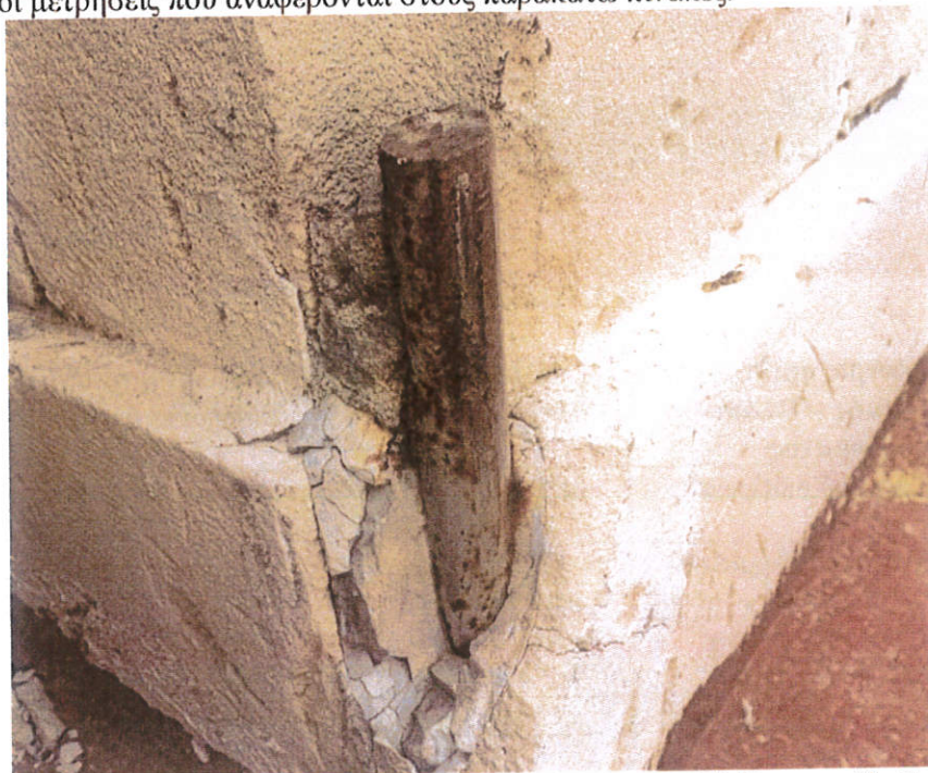
Εικόνα 4. Βόρειο Καμπαναριό προεξέχον τμήμα ανοξείδωτου χάλυβα
